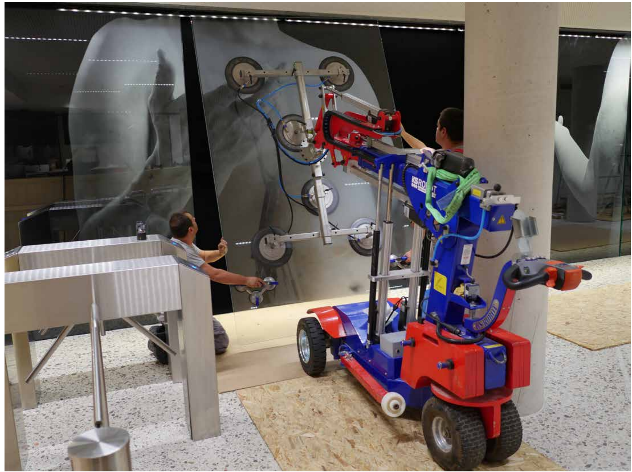
Montage der Glasplatten
