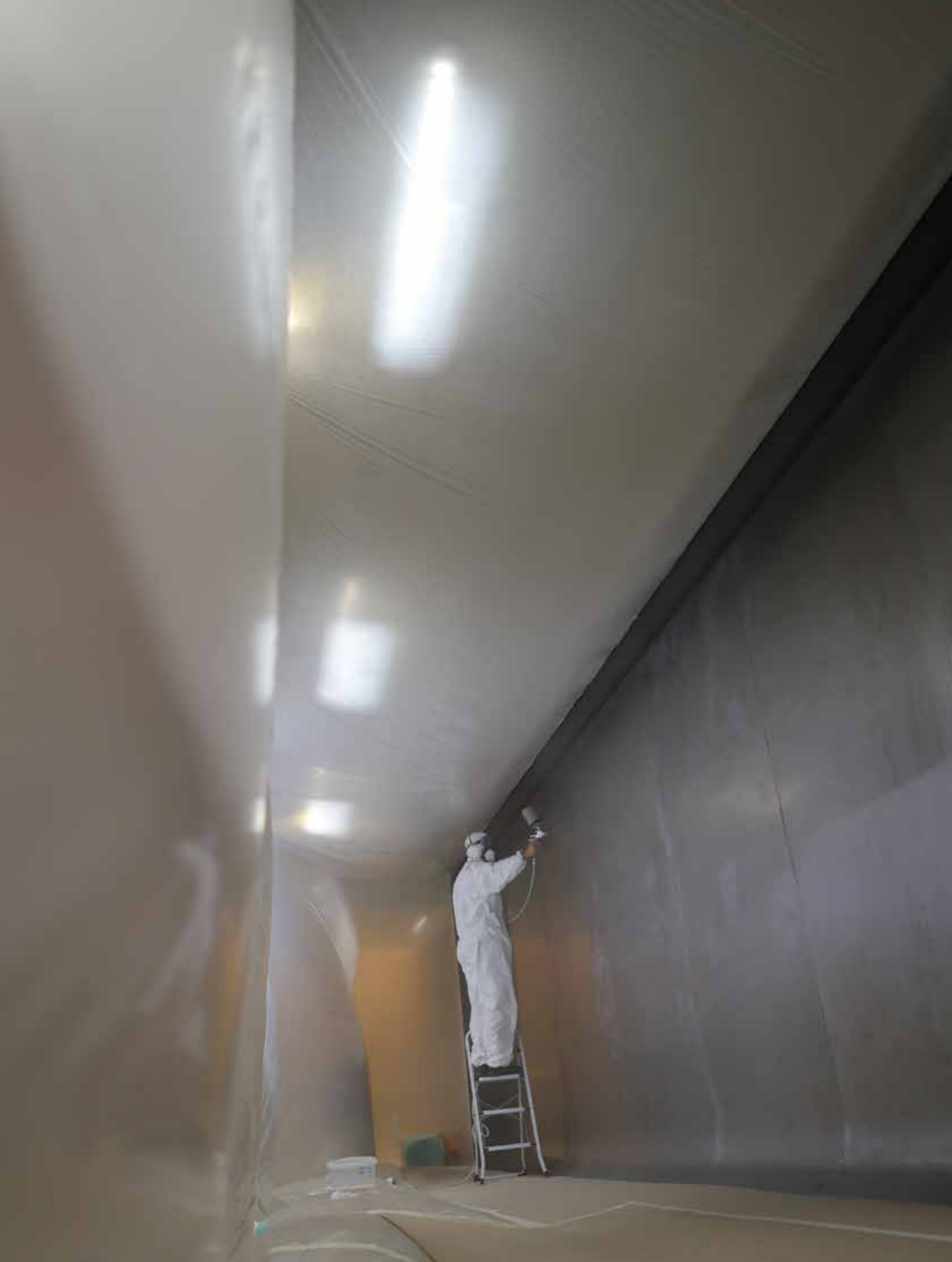
Lackierung des Metallhintergrunds
